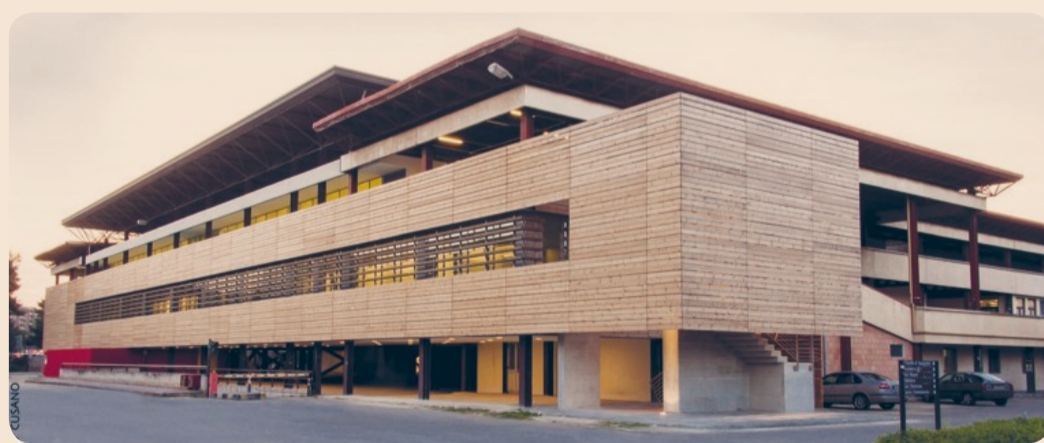
Lo Student centre nel campus universitario "Ernesto Quagliariello"
